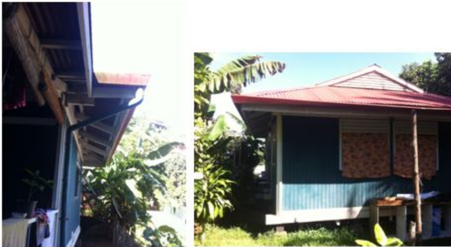
Figure 21 : protection solaire par débord de toiture sur la périphérie du bâtiment.
