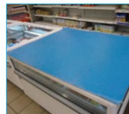
Plastique correctement positionné sur un meuble froid horizontal : rideau d'air supérieur à l'intérieur
