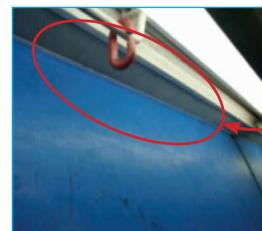
Plastique mal positionné sur un meuble froid vertical : rideau d'air supérieur à l'extérieur
